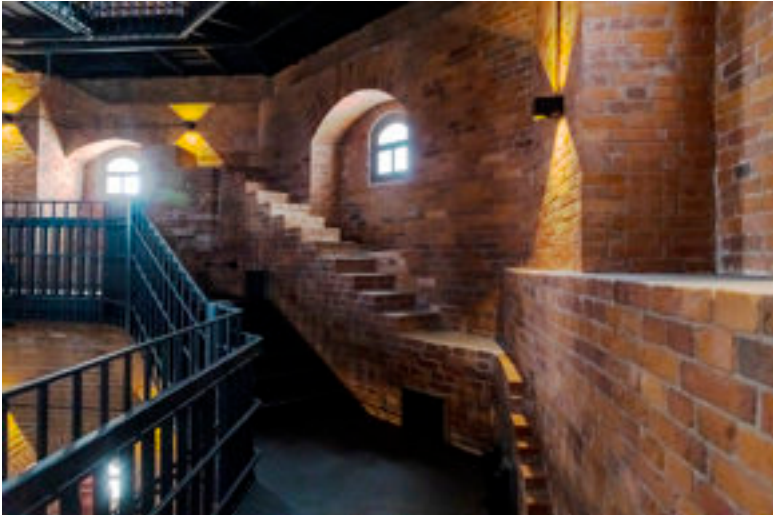
Restaurerat murverk och avsatser i tornet. Foto Aljona Golovatj.
