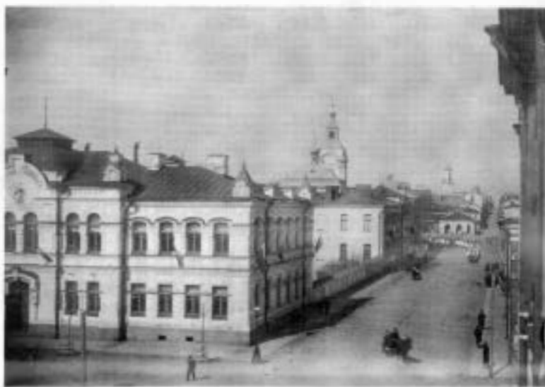
Fixeringsbild, tagen från ett tak vid Katrinegatan i hörnet av Alexandersgatan. I förgrunden ryska reallyceet, grundat 1918. Skolhuset byggdes 1886, då för ett ryskt flickgymnasium. Men intressantare är följande hus. Det var byggt i två våningar 1883-85 och inhyste ryska reallyceet. En våning påbyggdes 1906. Huset övertogs 1923 av Viipurin Suomalainen lyseo, som från 1930 hette Viipurin kaksoislyseo. Fotot bör alltså vara taget 1906.
