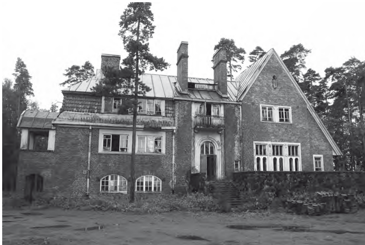
Fasaden med en del av takteglarna.
